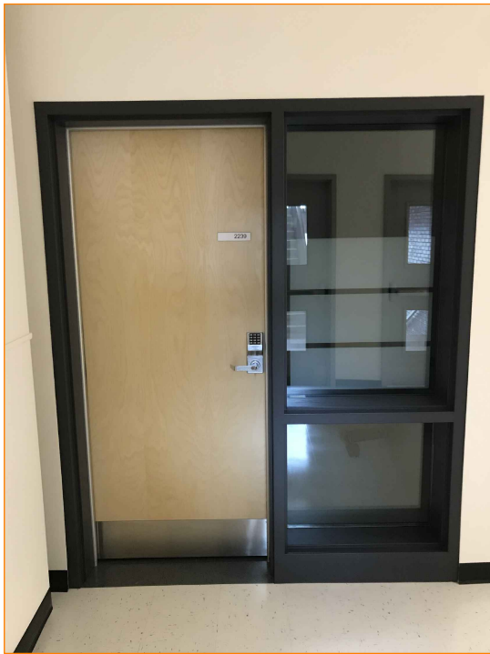
F PORTE PLEINE AVEC SECTION VITRÉE LATÉRALE PLUS DE 18"
