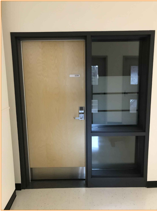
E PORTE PLEINE AVEC SECTION VITRÉE LATÉRALE MOINS DE 18"
