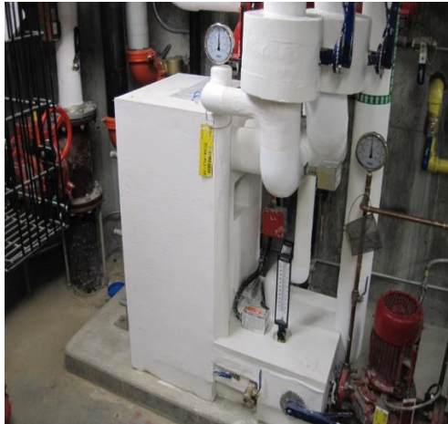
Photo 13. Échangeur à plaques
