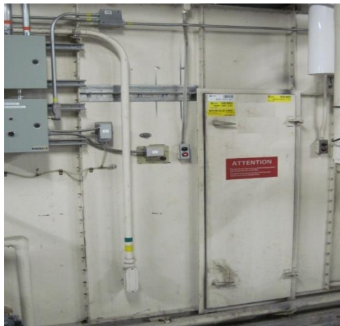
Photo 8. Ventilateur – moteur électrique
