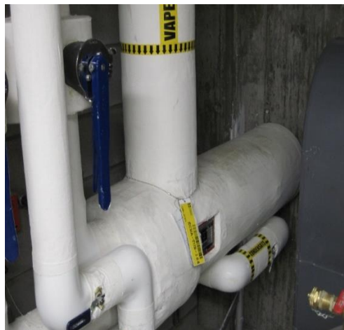
Photo 14. Échangeur à tubes
