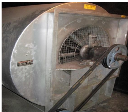
Photo 9. Ventilateur centrifuge
